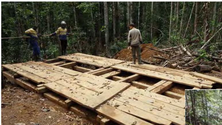
Vue de plateformes de sondage en bois construites par ARMINA.
