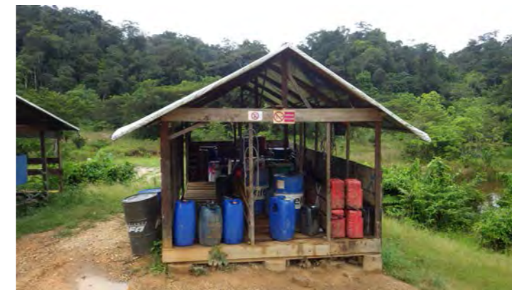
Réserves d'hydrocarbures, sur rétention étanche
