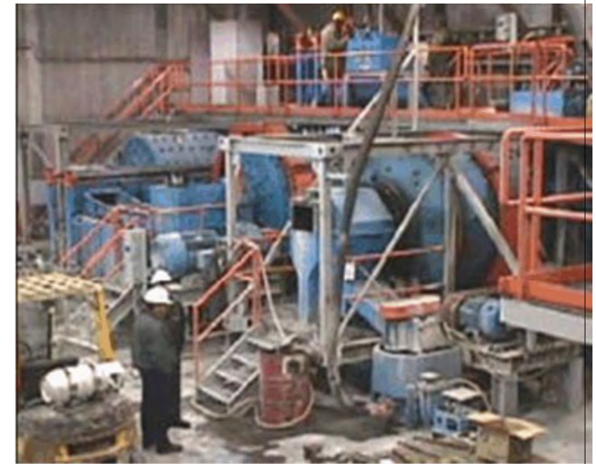
Unité UMTMA en cours de montage
