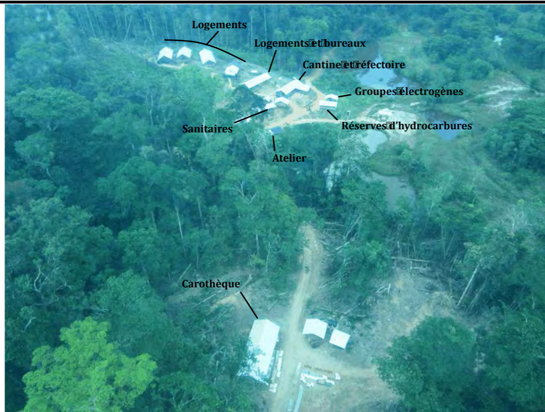
Vue aérienne du camp Wayamaga
