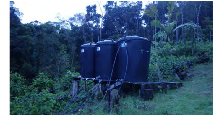
Réserves d'eau pompée pour le carbet sanitaire
