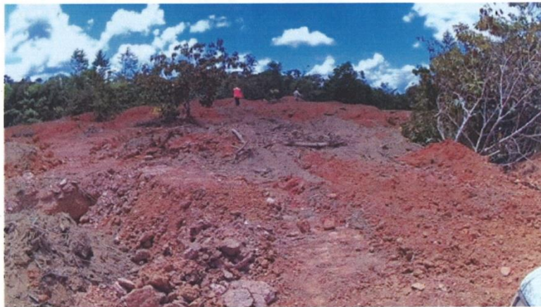
Photo 3 : Traitement de toutes les zones dénudées, ici sur le haut du relief de César, avec des modelés de fosses de plantation, pour des espèces forestières autochtones, remplies avec 1,5 à 2,5 m3 de terres humifères. Les terres excavées sont mises en remblais sous forme de demi-lune aval afin de piéger eau de ruissellement et d'éviter le départ de fines vers les bas-fonds ou bassins.
