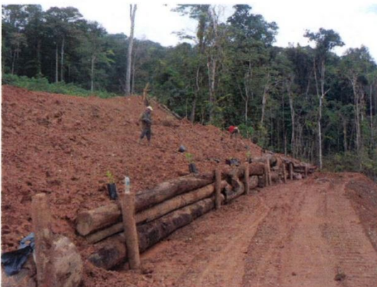
Photos 9 & 10 : Sur pente forte, les pistes de cloisonnements sont mis à profit pour édifier des clayonnages, à base de grumes et pieux enfoncés avec le godet d'une pelle mécanique. Cette opération est cependant coûteuse en temps de réalisation (tronçonnage, transport) et nécessite d'avoir, au préalable (= à la déforestation), mis de côté tous les bois résistants au contact du sol. Les grumes de gros diamètre seront préférées.
