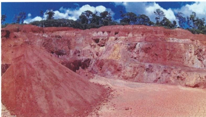
Photo 4 et 5 : Reprofilage de la colline Virgile Ouest. Ce vaste amphithéâtre à 5 niveaux sera ramené à 3 niveaux de terrasses, avec comblement des ravines puis ouverture de fosses de plantations. Les talus de déblais seront traités avec des bourrelets ré-enherbés selon méthode testée sur la digue Ovide.
