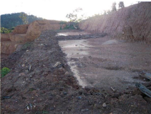
Photos 11 & 12 : Autre technique anti-érosive, la création de casiers de retenue des eaux pluviales. Réalisés sur un gradin de la fosse A, avec des bourrelets de terres humifères, disposés en U. Eaux et fines sont piégées et ne dévalent plus vers l'aval. Une végétation broussailleuse rudérale s'installe spontanément. A gauche réalisation en août 2011, à droite en décembre 2015 : les casiers restent fonctionnels même sans entretien, à condition d'avoir édifié des bourrelets suffisamment hauts et larges. Ces bourrelets peuvent également être faits avec des matériaux tout-venant, lorsqu'il s'agit de contenir des eaux de ruissellement pour une période temporaire.
