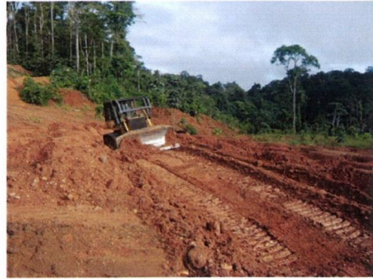
Photos 7 & 8 : Le traitement des zones à recultiver sur pente, consistera d'abord à cloisonner les versants de colline, à l'aide de pistes isohypses, à déverser amont. Ces pistes seront également empruntées, en conditions sèches, par les camions qui viendront déverser les terres humifères nécessaires pour réussir la recultivation : en effet les stériles miniers sont également des stériles biologiques.
