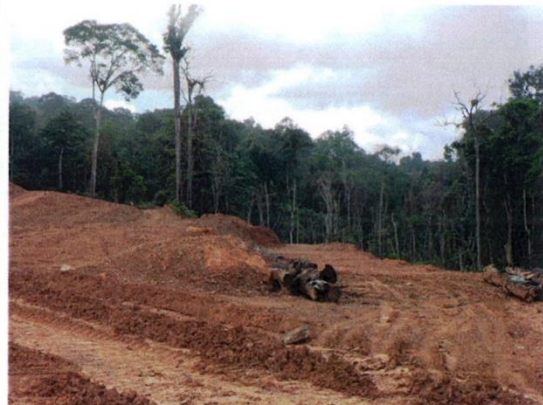
Photos 13 & 14 Suivi des travaux sur la fosse CL : Remblaiement en st erile minier et autres rebus de sous-sol - Cr eation d'une piste en bas de pente - pr eparation et transport des grumes pour  dification d'un clayonnage - juillet 2009.
