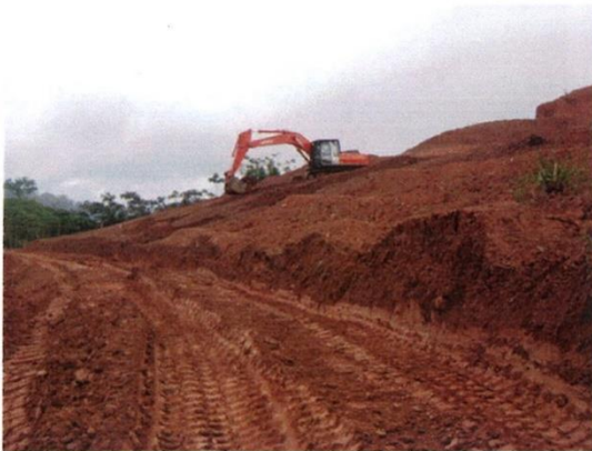
Photos 7 & 8 : Le traitement des zones à recultiver sur pente, consistera d'abord à cloisonner les versants de colline, à l'aide de pistes isohypses, à déverser amont. Ces pistes seront également empruntées, en conditions sèches, par les camions qui viendront déverser les terres humifères nécessaires pour réussir la recultivation : en effet les stériles miniers sont également des stériles biologiques.
