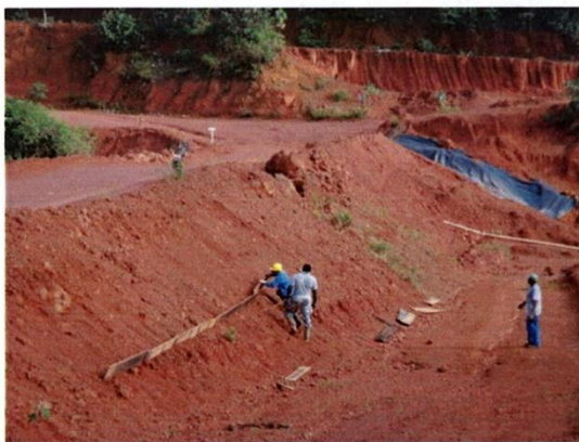
Photo 20 & 21 : Traitement du parement de la digue Ovide, avec bandes d'enherbement sur clayonnage temporaire. L'objectif est de stabiliser la surface de la digue, afin d'éviter l'érosion en micro-ravines du parement. A gauche installation en juin 2015, à droite en juillet 2016.
