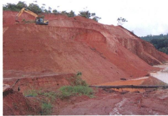
Photos 1 & 2 : Traitement en reprofilage de la colline César Sud, flanc Nord en vis à vis de l'usine gravimétrique. A gauche photo en décembre 2015 état avant-travaux, à droite début des travaux en mars 2016. Reprofilage en large banquette, avec talus de déblais foisonnés. Toutefois les travaux entrepris en début d'année 2016 ont dû être suspendu, car les conditions hors grande saison sèche ne permettent pas d'obtenir des résultats suffisamment satisfaisants. Il faut pouvoir combiner travaux de modelés du sol, avec apport des terres humifères simultanément.
