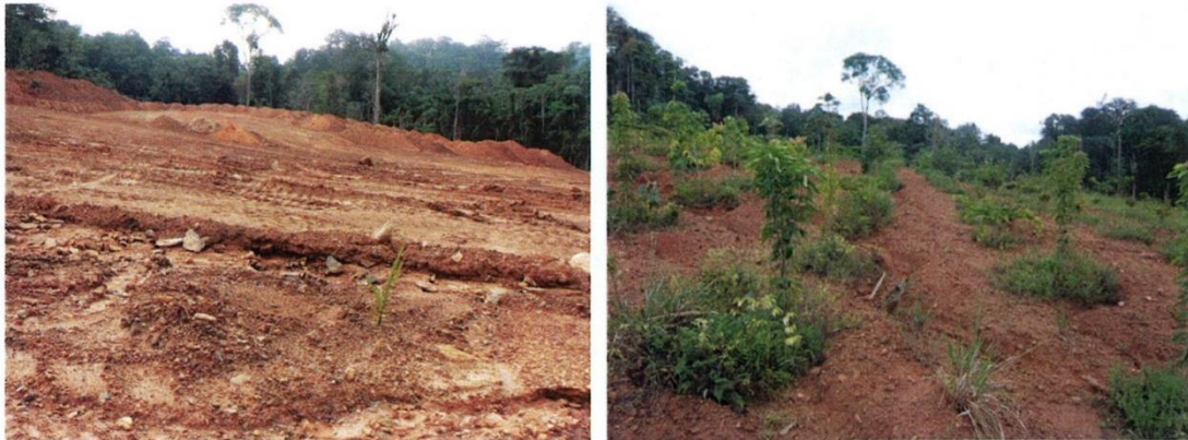
Photos 19 & 20 = autre point de vue photographique de suivi, toujours sur la fosse CL :   gauche en juillet 2009, avec les tas rapport s par les tombereaux, qui sont ensuite r egal s au boteur. La colline  tant alors progressivement remblay e par strate successive, avec intercalation des glacs dus   la circulation des engins.   droite en juillet 2012, les plantations foresti res et fruiti res (mai 2011), mais avec ravines qui ont travers  le versant. A noter que les adventices ne se d veloppent quasiment que dans les fosses remplies de terres humif res.
