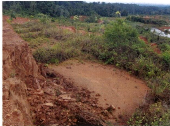
Photos 11 & 12 : Autre technique anti-érosive, la création de casiers de retenue des eaux pluviales. Réalisés sur un gradin de la fosse A, avec des bourrelets de terres humifères, disposés en U. Eaux et fines sont piégées et ne dévalent plus vers l'aval. Une végétation broussailleuse rudérale s'installe spontanément. A gauche réalisation en août 2011, à droite en décembre 2015 : les casiers restent fonctionnels même sans entretien, à condition d'avoir édifié des bourrelets suffisamment hauts et larges. Ces bourrelets peuvent également être faits avec des matériaux tout-venant, lorsqu'il s'agit de contenir des eaux de ruissellement pour une période temporaire.
