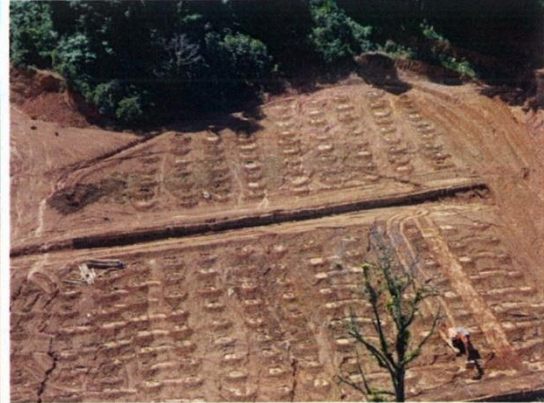
Photos 25 & 26 : Suivi photographique des plantations arbor es sur la fosse Aest :   gauche en juillet 2009, carreau non encore compl ttement remblay .   droite, prise de vue en mai 2011 pendant le chantier de plantation : en d pit de la tr s bonne reprise et croissance des arbres, deux points techniques sont   corriger pour les futures pr parations, d'une part les clayonnages doivent  tre isohypses et d'autre part les demi-lunes doivent  tre implant es en quinconce.   noter la courbe   l'amont qui indique la mise en place imm diate du glissement de terrain .
