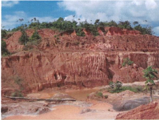
Photos 1 & 2 : Traitement en reprofilage de la colline César Sud, flanc Nord en vis à vis de l'usine gravimétrique. A gauche photo en décembre 2015 état avant-travaux, à droite début des travaux en mars 2016. Reprofilage en large banquette, avec talus de déblais foisonnés. Toutefois les travaux entrepris en début d'année 2016 ont dû être suspendu, car les conditions hors grande saison sèche ne permettent pas d'obtenir des résultats suffisamment satisfaisants. Il faut pouvoir combiner travaux de modelés du sol, avec apport des terres humifères simultanément.
