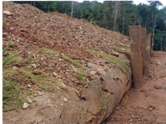
Photos 9 & 10 : Sur pente forte, les pistes de cloisonnements sont mis à profit pour édifier des clayonnages, à base de grumes et pieux enfoncés avec le godet d'une pelle mécanique. Cette opération est cependant coûteuse en temps de réalisation (tronçonnage, transport) et nécessite d'avoir, au préalable (= à la déforestation), mis de côté tous les bois résistants au contact du sol. Les grumes de gros diamètre seront préférées.
