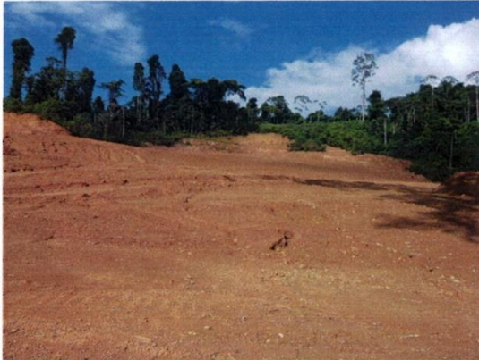
Photos 25 & 26 : Suivi photographique des plantations arbor es sur la fosse Aest :   gauche en juillet 2009, carreau non encore compl ttement remblay .   droite, prise de vue en mai 2011 pendant le chantier de plantation : en d pit de la tr s bonne reprise et croissance des arbres, deux points techniques sont   corriger pour les futures pr parations, d'une part les clayonnages doivent  tre isohypses et d'autre part les demi-lunes doivent  tre implant es en quinconce.   noter la courbe   l'amont qui indique la mise en place imm diate du glissement de terrain .
