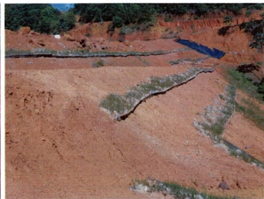
Photo 20 & 21 : Traitement du parement de la digue Ovide, avec bandes d'enherbement sur clayonnage temporaire. L'objectif est de stabiliser la surface de la digue, afin d'éviter l'érosion en micro-ravines du parement. A gauche installation en juin 2015, à droite en juillet 2016.
