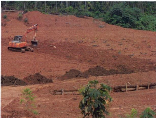
Photos 15 & 16 : Chantier de plantation (  droite - mai 2010), o  toutes les op erations de plantation sont men es simultan ement (profilage, ouverture des fosses, remplissage de terres humif eres, distribution des plants et mise en terre). M eme point de vue (  gauche - octobre 2010), en pleine saison s echer. Le foisonnement dans les fosses de plantation et les profils en demi-lunes engendrent une r eserve d'eau qui dispense d'avoir   arroser en saison s echer les plants r ecemment mis en terre. Pourtant le passage de la premi ere saison s echer est crucial pour des plantations.
