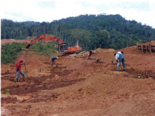
Photos 27 & 28 : Chantier de plantation sur Aest (mai 2011) et premiers effets des pluies (juillet 2011) : vue rapproch e sur le fa onnement des demi-lunes, le remplissage des fosses (2   3 m 3 ) en terres humif res.   droite, la demi-lune a pi g  les eaux et fines qui ont ruissel  de l'amont.
