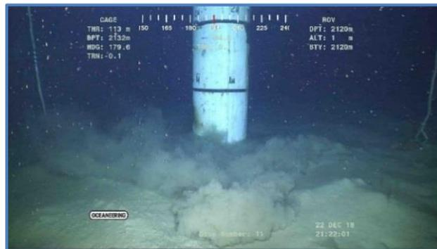
Figure 5: Fonçage du tube guide 36"
