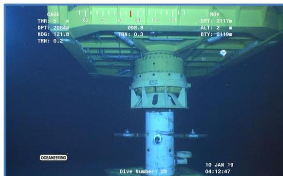
Figure 6: Pose du BOP sur la tête de puits
