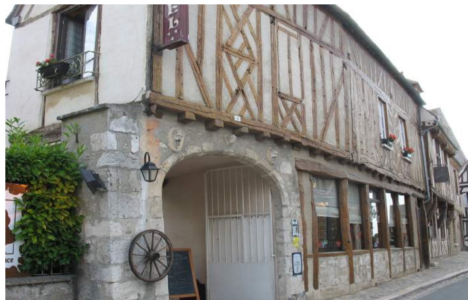
Construction en bois et torchis dans la ville médiévale de Provins
