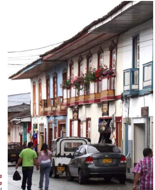
Constructions en terre faites de pisé à la base et de torchis (bahareque) à l'étage © Beatriz Helena Ramirez Gonzalez
