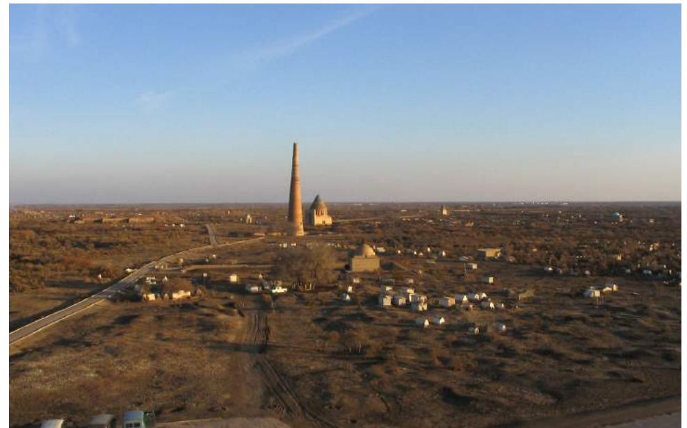
Vue générale avec le minaret de Kultug Timur haut de 60 mètres © Sébastien Moriset, CRATerre
