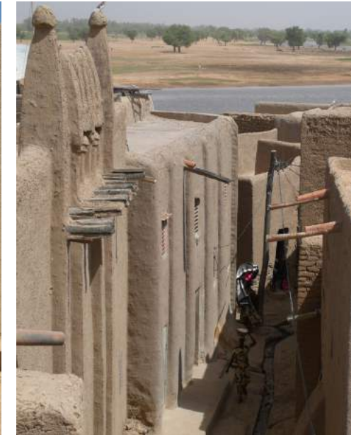
Une rue du quartier Sankoré, vue depuis une terrasse © Thierry Joffroy, CRAterre
