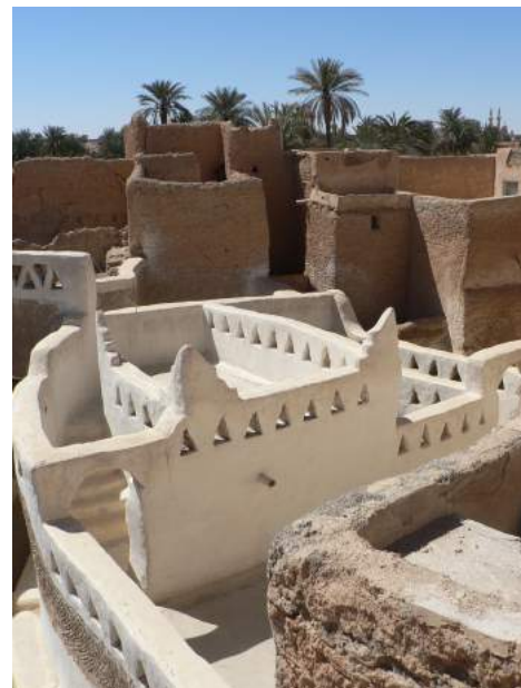
Toitures avec acrotères enduites de plâtre © Thierry Joffroy, CRAterre
