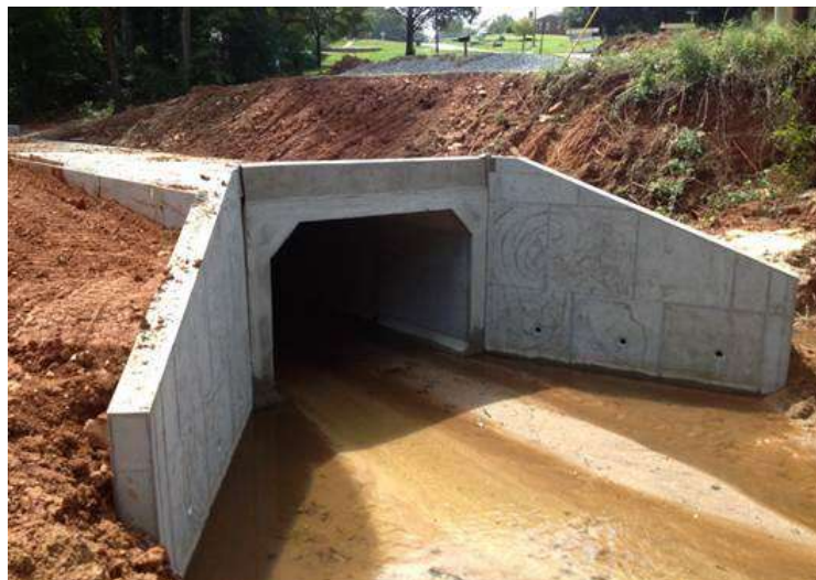
Figure 24 : Principe de voile béton en entrée ou sortie de dalot
