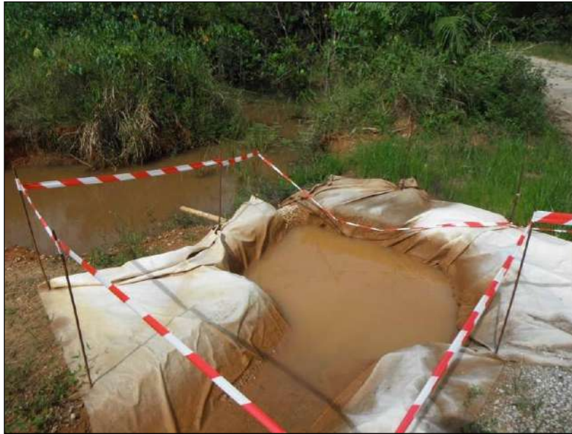
Figure 27 : Exemple d'ouvrage de piégeage des matières en suspension à l'exutoire d'un fossé
