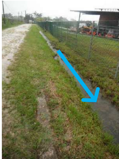
Figure 23 : Exemple de fossé situé en pied de talus de voirie
