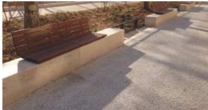
Figure 1. Muret béton et lattage bois
