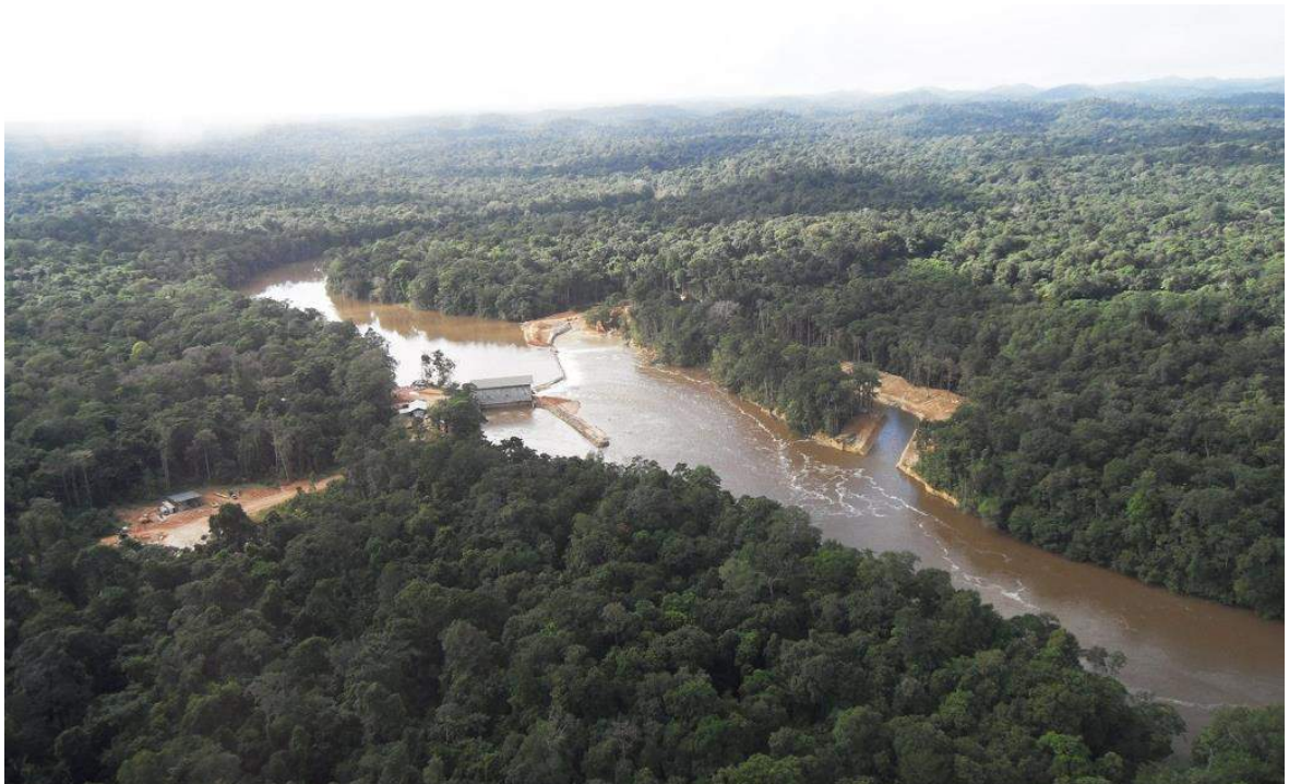
Fig. 1. Centrale hydro-électrique de Saut Maman Valentin (VOLTALIA)
