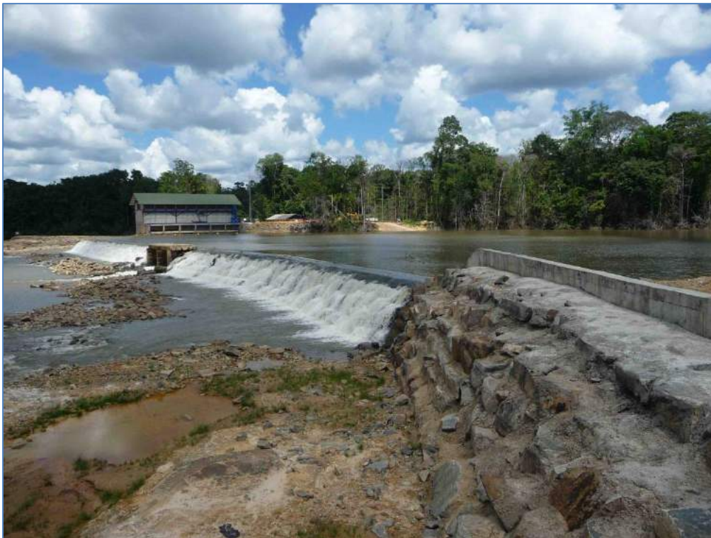
Fig. 3. Les surverses : un moyen efficace de s'assurer une bonne oxygénation et une bonne qualité des eaux de l'Inini. Ici la centrale de Saut Maman Valentin (S. Clavier / HYDRECO)
