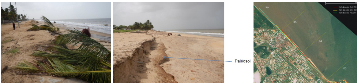
Dégâts sur la plage de Kourou suite aux submersions marines de février 2016 (source : BRGM et DEAL Guyane, Rapport d'expertise, CR des épisodes de submersions marines de février 2016 à Kourou, BRGM/RP-65691-FR, 2016).
