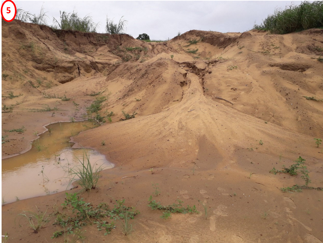
Figure 4 : Talus de stockage (Suez consulting Février 2022)
