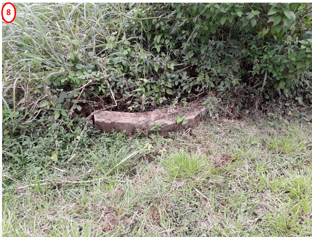
Figure 7: Tête de rejet central, dans l'axe de l'écoulement repéré au nord du talus de stockage (Suez consulting Février 2022)
