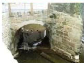
En 2007 une quatrième arche est découverte et réouverte afin d'améliorer l'écoulement des eaux. En aval 300 m<sup>3</sup> de roches sont enlevées du lit de l'Ellé dans le même but.
