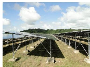
Figure 15 : structure métallique des actuels panneaux solaires, stabilisée par des plots de béton déposés au sol
