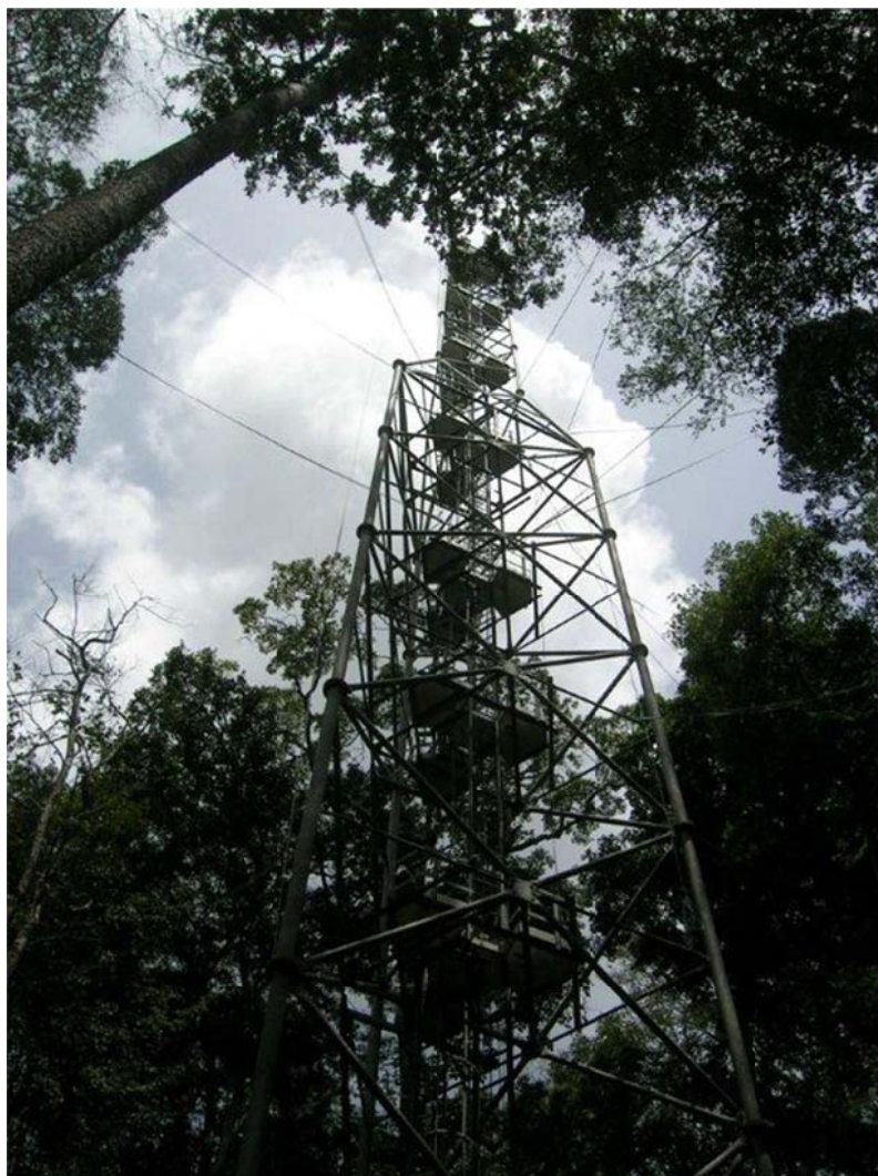
Figure 19 : Tour GUYAFLUX installée à Paracou pour mesurer les échanges forêt – atmosphère (source BRGM Guyane)
