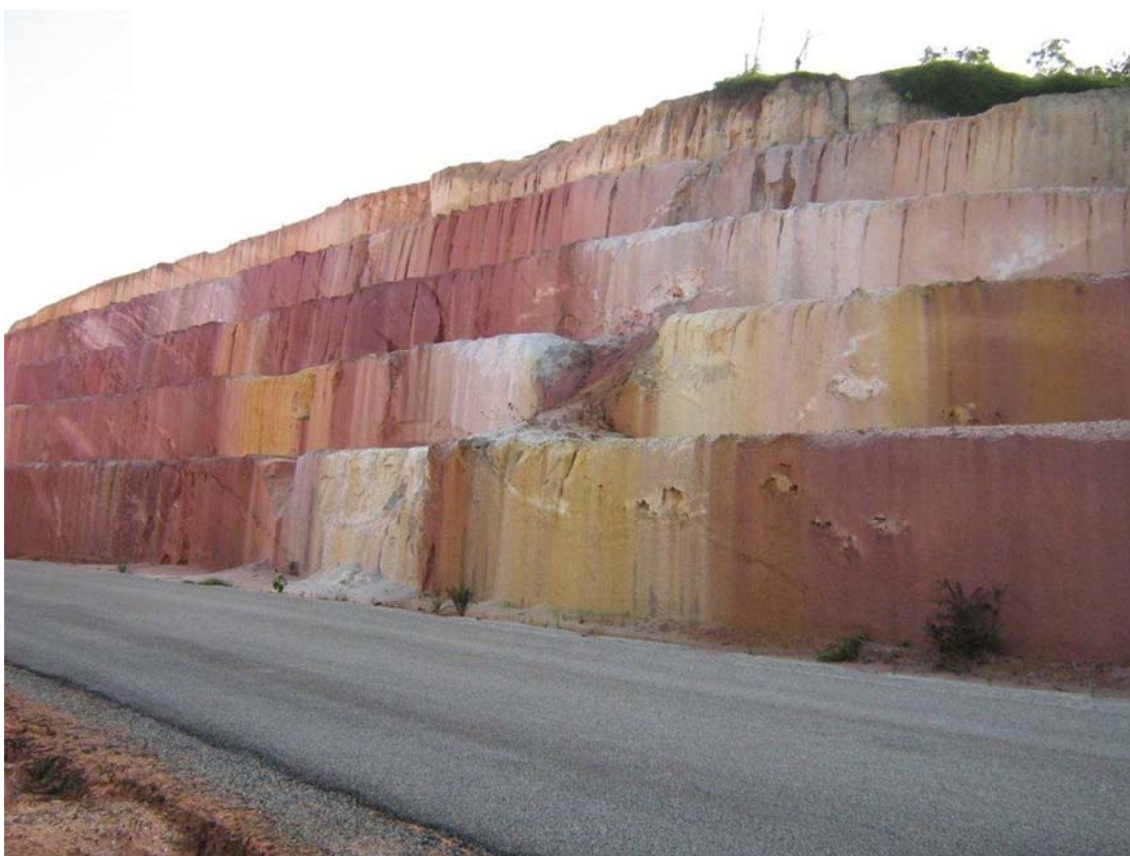
Figure 5 : Profil d'altération le long de la route St Laurent Apatou (source BRGM Guyane)
