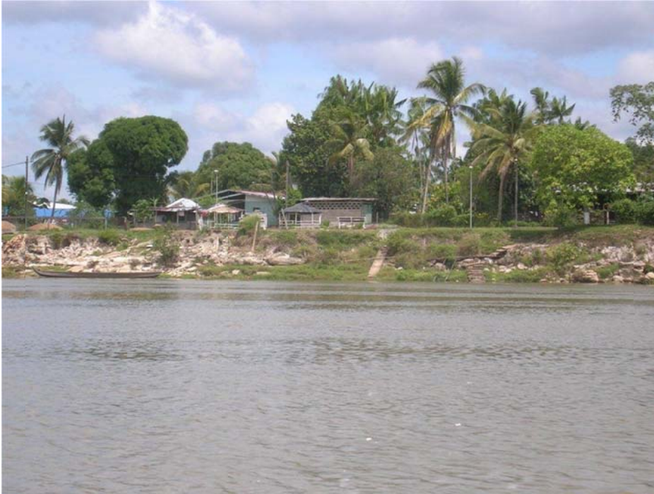
Figure 51 : Installations dispersées le long du Maroni (source BRGM Guyane)
