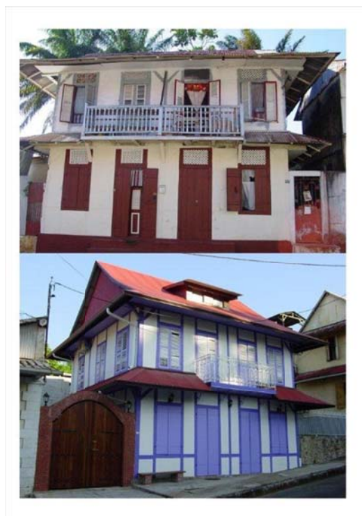
Figure 53 : Anciennes maisons créoles rénovées à Cayenne (source BRGM Guyane)
