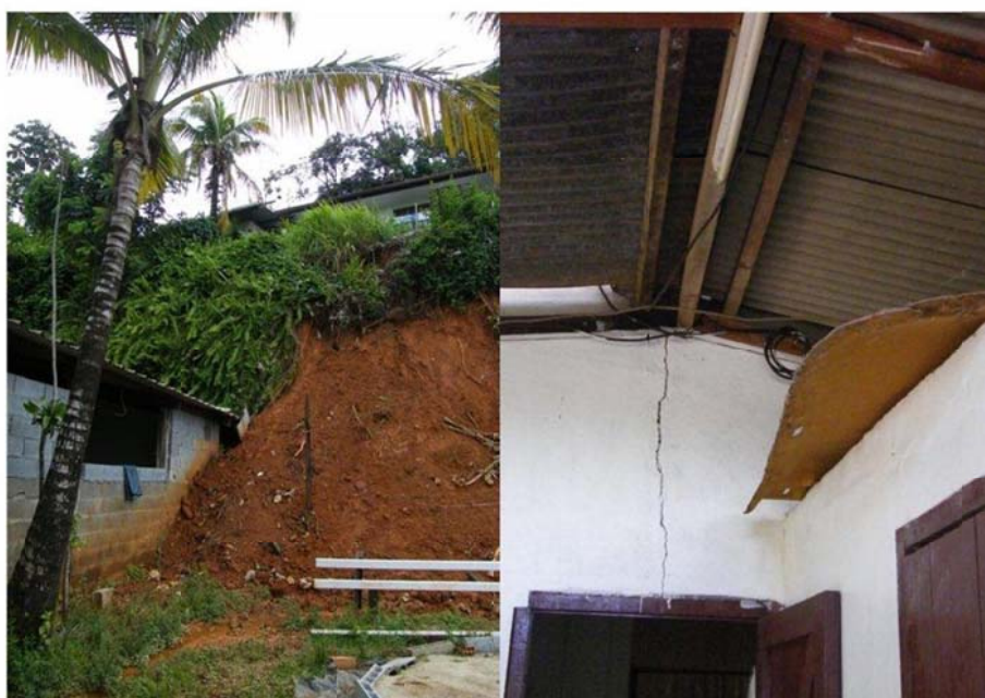
Figure 39 : Glissements de terrain sur la colline de Baduel en 2009 à Cayenne (source BRGM Guyane)
