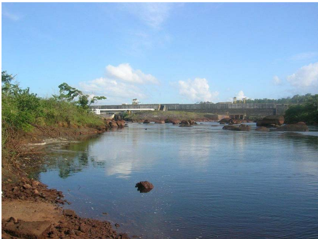
Figure 15 : Vue du barrage de Petit Saut (source BRGM Guyane)
