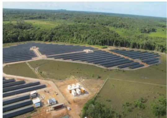
Centrale photovoltaïque de Toucan mise en service fin 2014 (source : EDF Energies Nouvelles)
