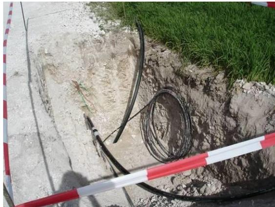
**Figure 55 : Exemple de tranchée accueillant le câblage électrique**
