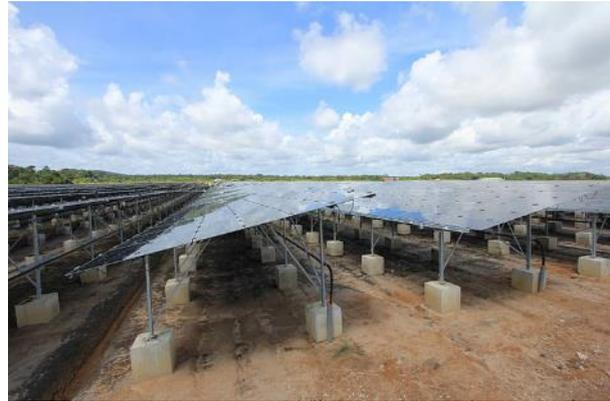
Figure 52 : Ancrage sur plots béton
