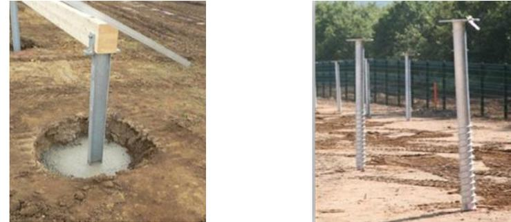
**Photographie 4 : Fondation béton (à gauche) ; fondation vis (à droite)**
