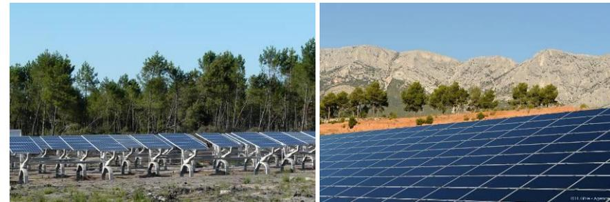
Photographie 1 : Structures solaires (à gauche: les trackers de la centrale de Gabardan (40) qui suivent le soleil ; à droite : structures fixes à Puylobouier (13)) - Source : EDF
