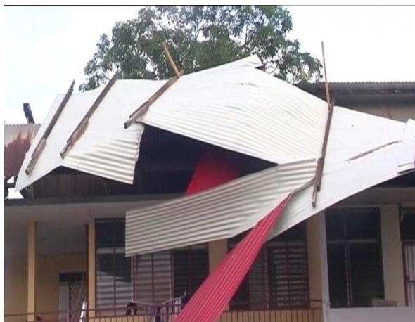
Un toit détruit par la micro-rafale de janvier 2013 (Source : Guyane 1ère)
