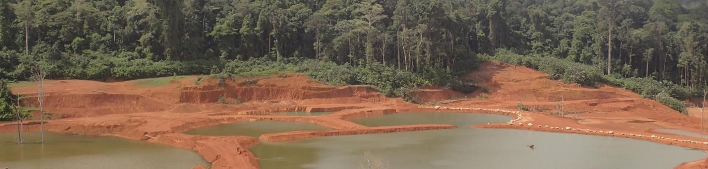
> Système de digues et bassins sur le secteur Saint-Auguste – Mine de Saint-Elie
