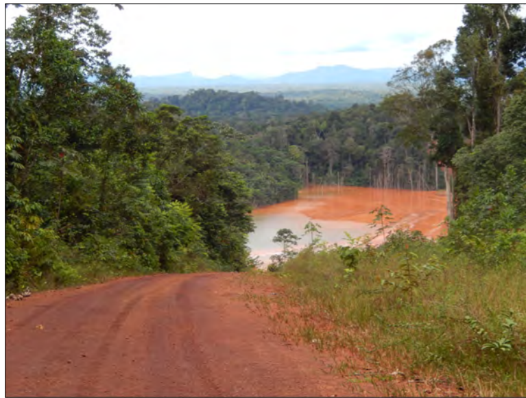
1) Entrée du site, vue sur le bassin Alpha en eau et la digue D2 à droite
