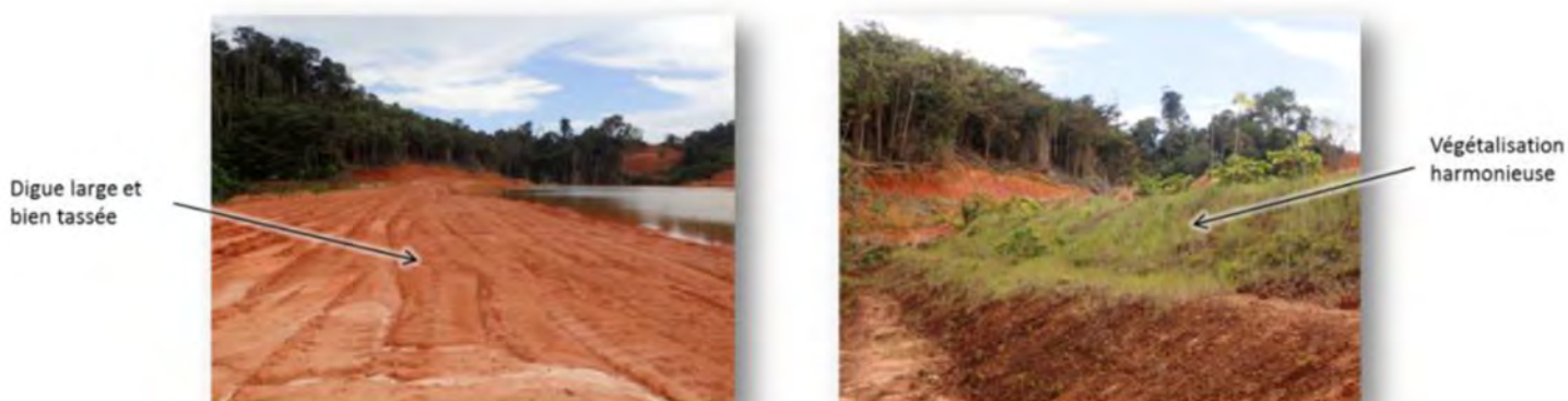
Photographie de la digue D DEV 7, la digue est en très bon état, en plus d'être correctement végétalisée. Elle assure la retenue du bassin « delta » ou B DEV 7, assurant la décantation des eaux de surfaces issues de l'usine et de la base vie
