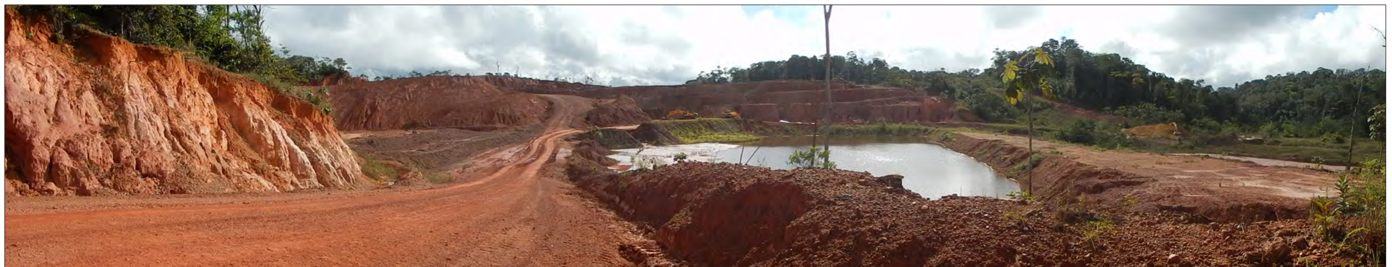
8) Vue sur le chantier primaire saprolitique de la zone de Chemin de fer Nord, vers à stériles en cours de terrassement en vue de sa végétalisation (arrière plan à gauche de la piste)
