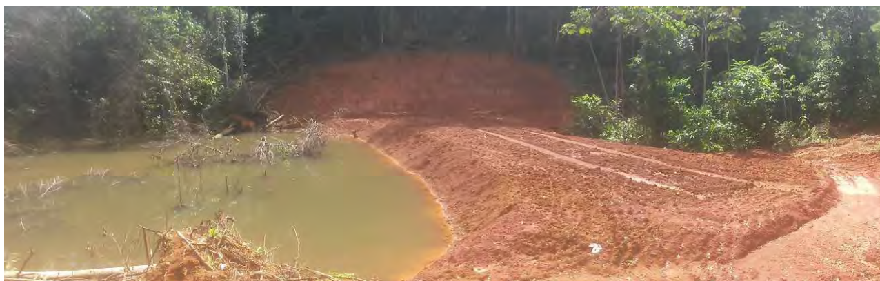
Photographie de la nouvelle digue DMIC7
