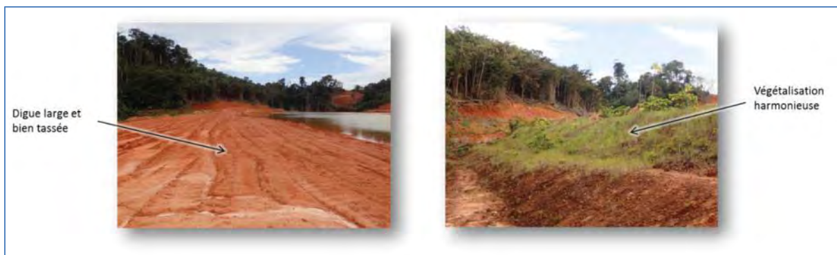
Figure 16 : photographie de la digue D DEV 7, la digue est en très bon état, en plus d'être correctement végétalisée. Elle assure la retenue du bassin « delta » ou B DEV 7, assurant la décantation des eaux de surfaces issues de l'usine et du campement.
