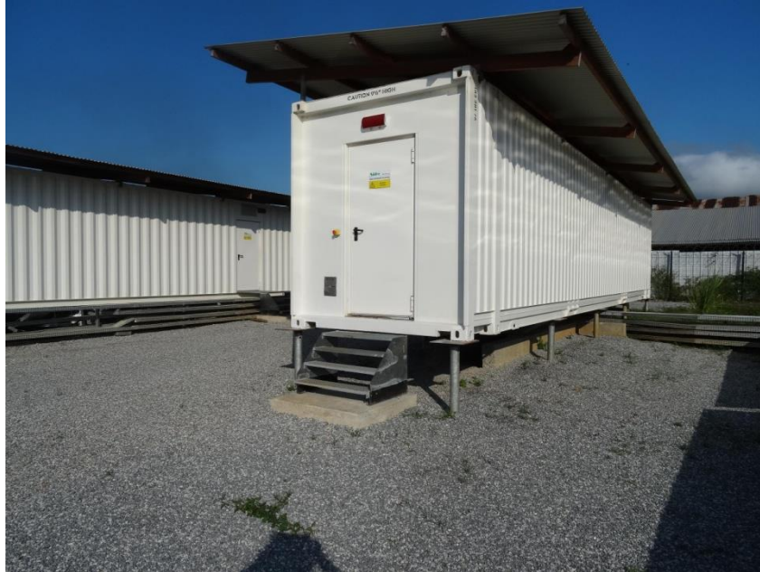
Poste de transformation type
