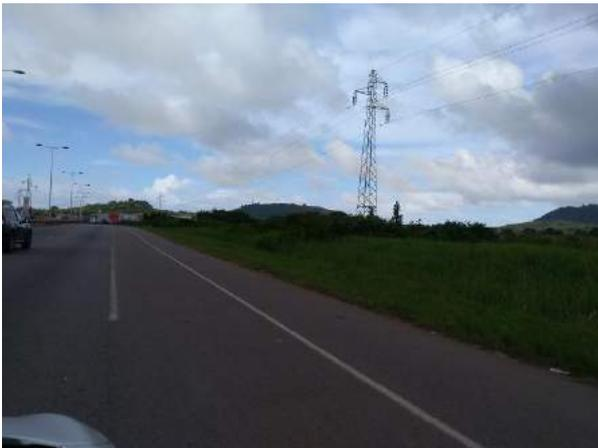
Bandes cyclables sur la RN1 enregistrant 47.000 véh/j et une limitation de vitesse à 90 km/h. Même si l'infrastructure est spatialement éloignée de la chaussée, il n'y a pas de séparation physique (segment 21)
