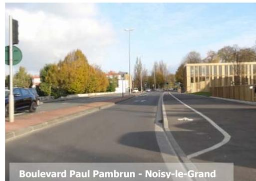
☹ Ne pas aménager une piste cyclable au bord de la chaussée lorsque l'on a une bordure haute de trottoir (risque de chute).
