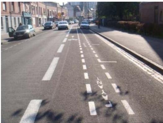
☺ Exemple de bande cyclable le long du stationnement avec une surlargeur de 0,50m,
