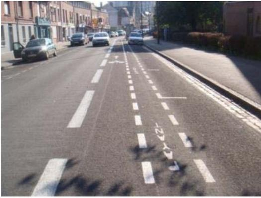
Exemple de double sens cyclable matérialisé par une bande le long du stationnement, avec une surlargeur de 0,50m,.
