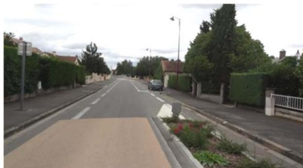
😊 *Exemple d'écluse couplée avec un by-pass permettant le passage des cyclistes (Rue des Bondoires, Saint-Doulchard)*
