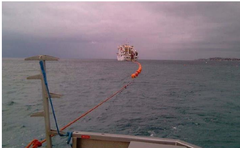
Figure 15 : Exemple de tirage d'un câble depuis un navire câblé vers la plage (Orange Marine)
