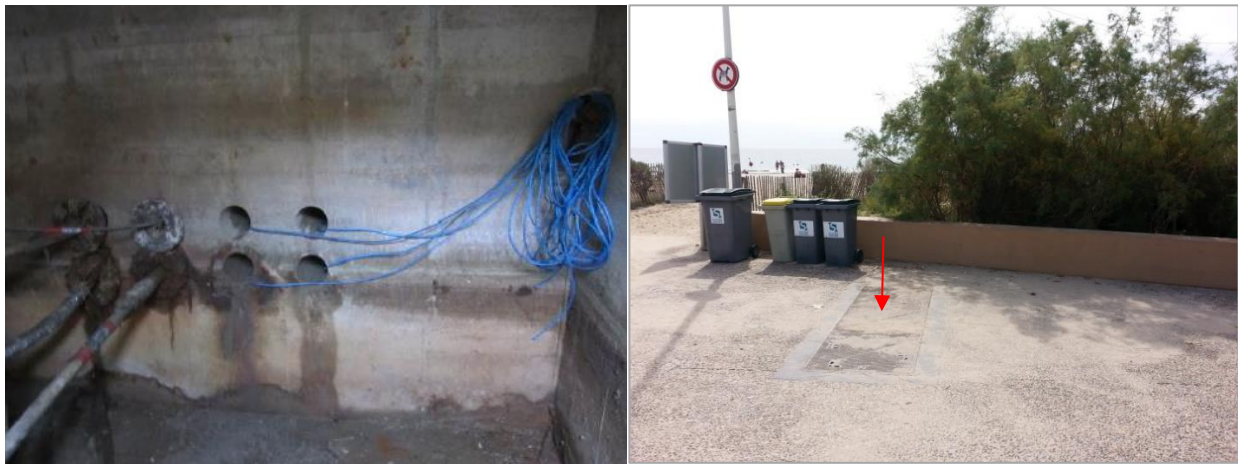
Figure 6 : Vues intérieure et extérieure d'une chambre-plage (Orange Marine, setec in vivo)
