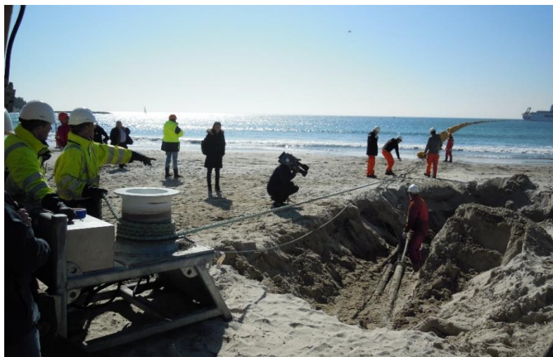
Figure 16: Opération de tirage du câble avec un cabestan hydraulique
