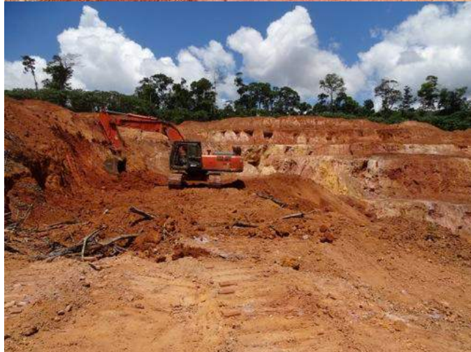
Photo 4 et 5 : Reprofilage de la colline Virgile Ouest. Ce vaste amphithéâtre à 5 niveaux sera ramené à 3 niveaux de terrasses, avec comblement des ravines puis ouverture de fosses de plantations. Les talus de déblais seront traités avec des bourrelets ré- enherbés selon méthode testée sur la digue Ovide.
