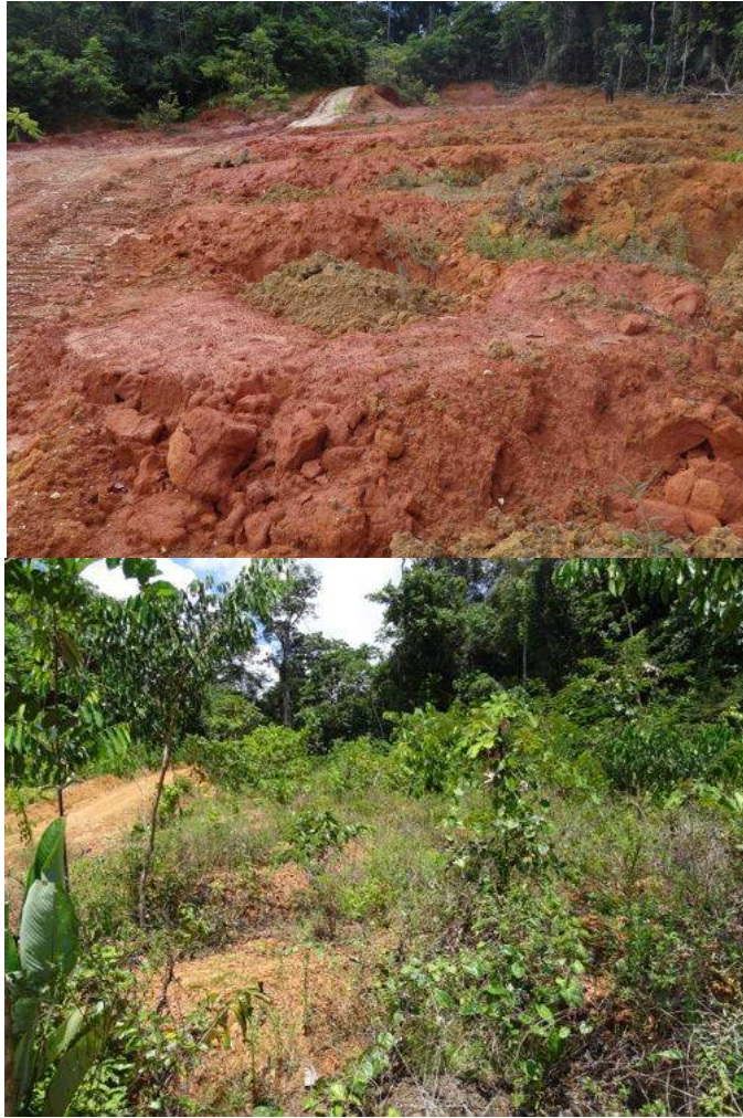
Photos 8 & 9 & 10 : Restauration écologique sur la zone Digue n°6.
