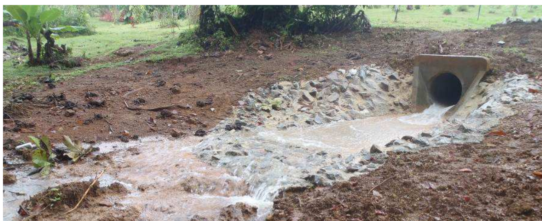
Figure 5. Vue d'un ouvrage de dissipation similaire à celui qui sera réalisé
