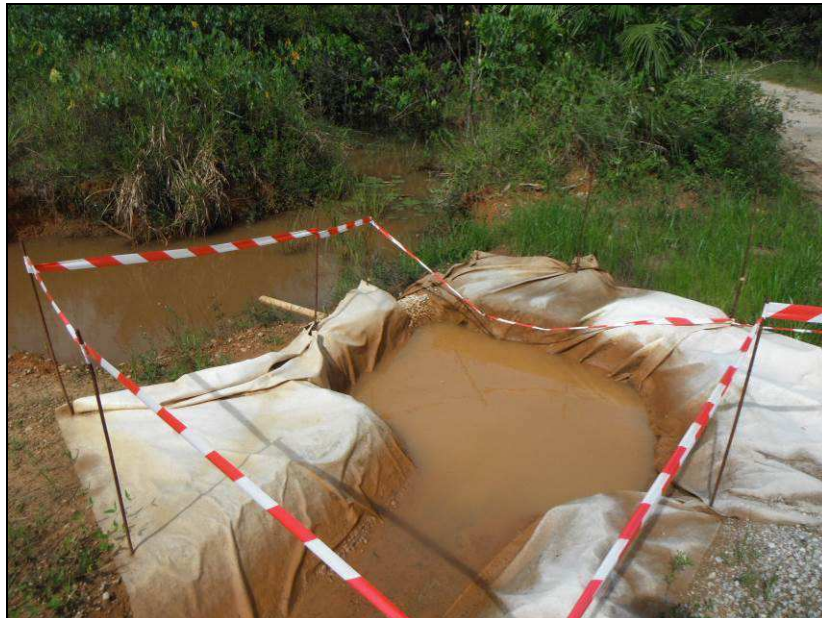
Figure 6 : Exemple d'ouvrage de piégeage des matières en suspension à l'exutoire d'un fossé
