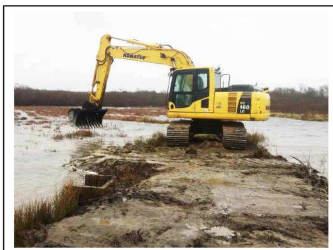
Figure 79 : Exemple de travaux en avancée sur marais – SLAT
