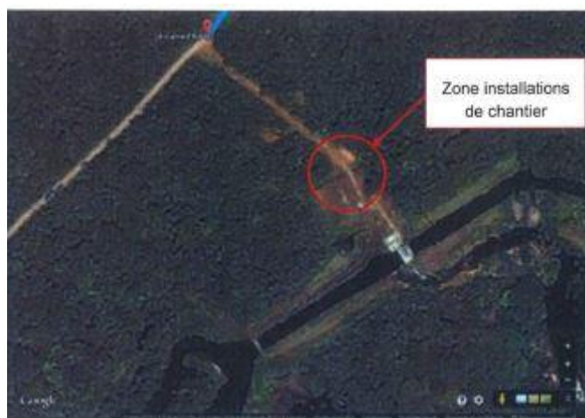
Zone d'installation de chantier (source : HSM)
