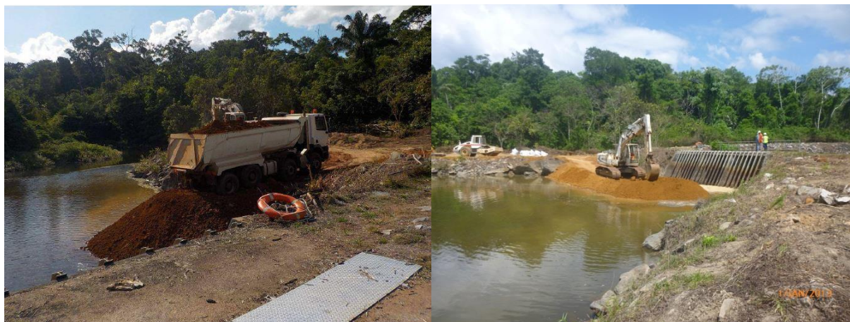
Mise en œuvre du batardeau amont lors des travaux de 2014 (source : EDF/HSM)
