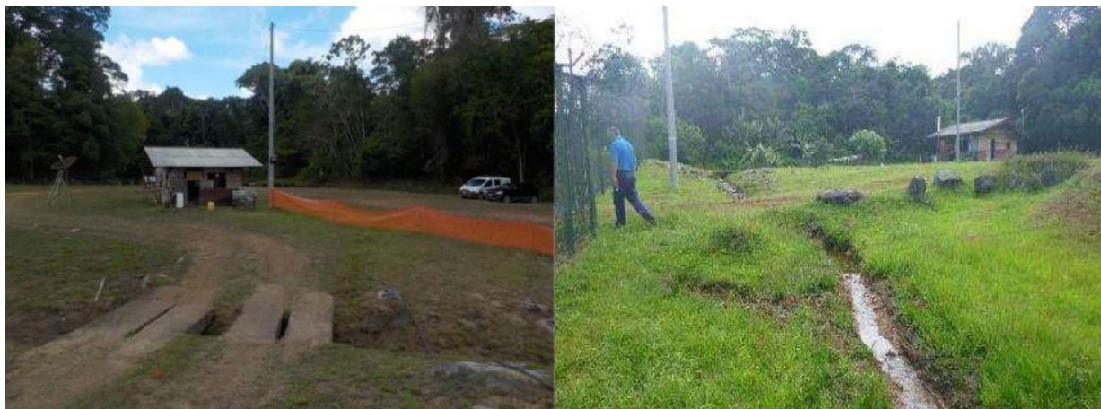
Poutres à remplacer et fossé humide à traiter à l'entrée de l'usine (source : HSM)
