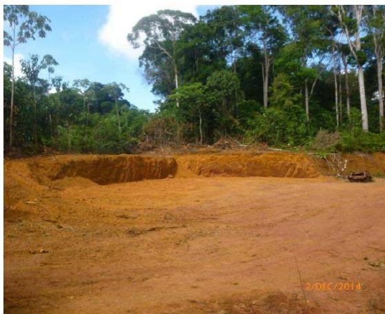
Vue du front de prélèvement de la latérite dans le cadre des travaux de 2014 (source : EDF/HSM)
