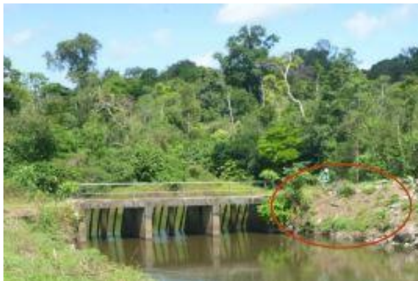
Berge à conforter (source : HSM, 2016)
