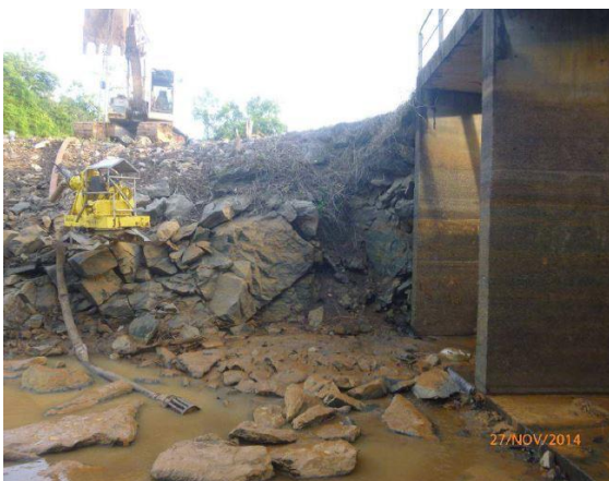
Pompe d'épuisement de surface avec tube plongeur équipé d'une crépine (source : EDF/HSM, 2014)
