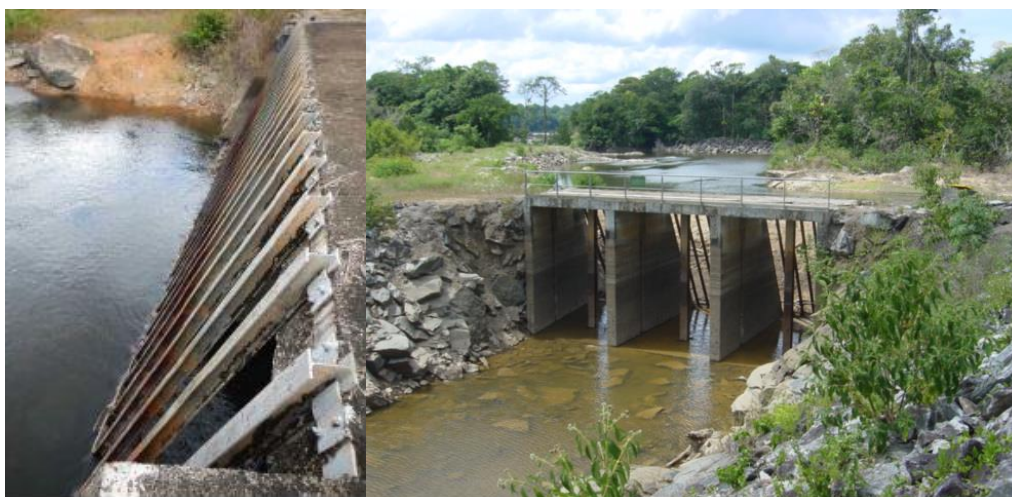
Pré-grilles à l'entrée du canal d'aménée (source : HSM)
