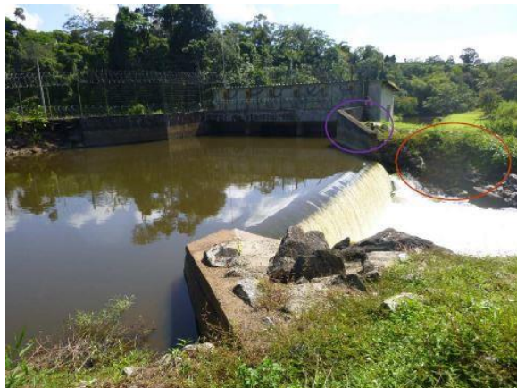
Confortement de la berge à réaliser en prolongeant la voile existant (cercle rouge) (source : HSM, 2016)
