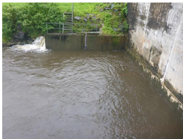
Impact de la crue sur l'échantillonnage autour de la centrale hydroélectrique (© Hydreco Guyane)
