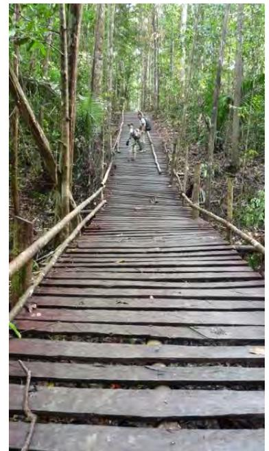
*Figure 54 : Platelage mis en place par Newmont pour faciliter la montée des quads et limiter l'érosion. ©C.*
