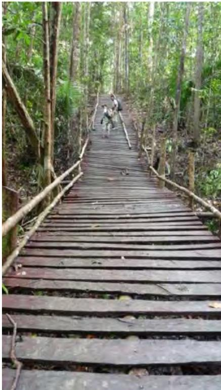
Platelage mis en place par NEWMONT LaSource pour faciliter la montée des quads et limiter l'érosion. (photographie BIOTOPE, PER de Bon Espoir)
