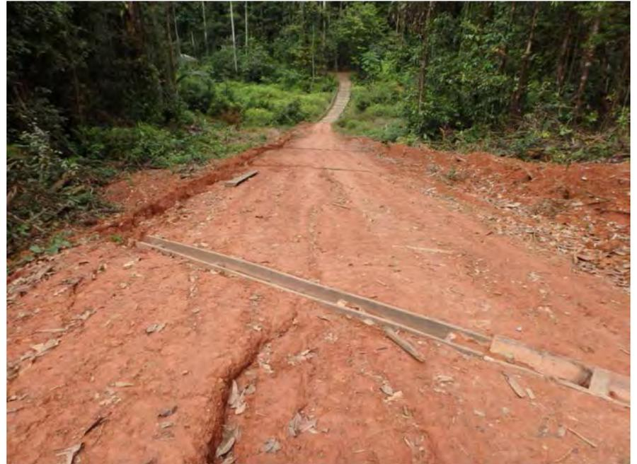
Illustration des fossés de drainage et de dérivation des eaux de ruissellement mis en place par NEWMONT LaSource pour limiter l'érosion le long des pistes (photographie NEWMONT LaSource, PER de Bon Espoir)
