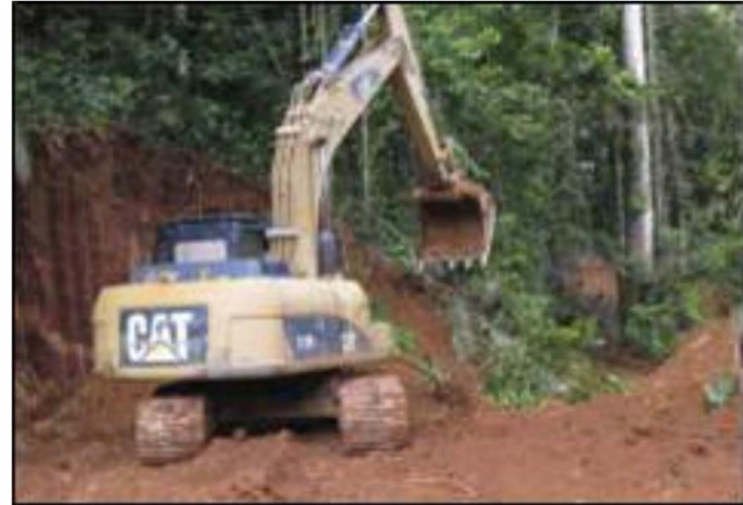
Terrassement à la pelle mécanique d'une plate-forme de sondage d'estimation (environ 10 x 10 m)
